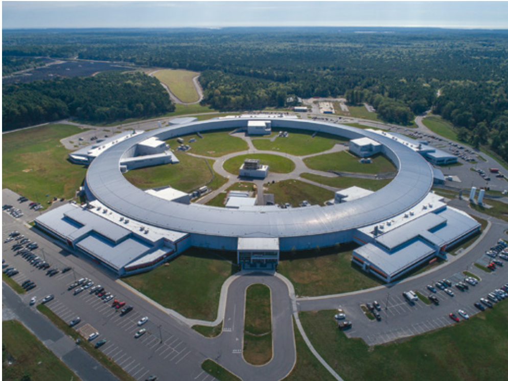
Εικόνα 4: Το Σύγχροτρο στο Brookhaven National Laboratory των ΗΠΑ (περιφέρεια 792 μέτρα, ενέργεια 3.0 GeV) 7 .
